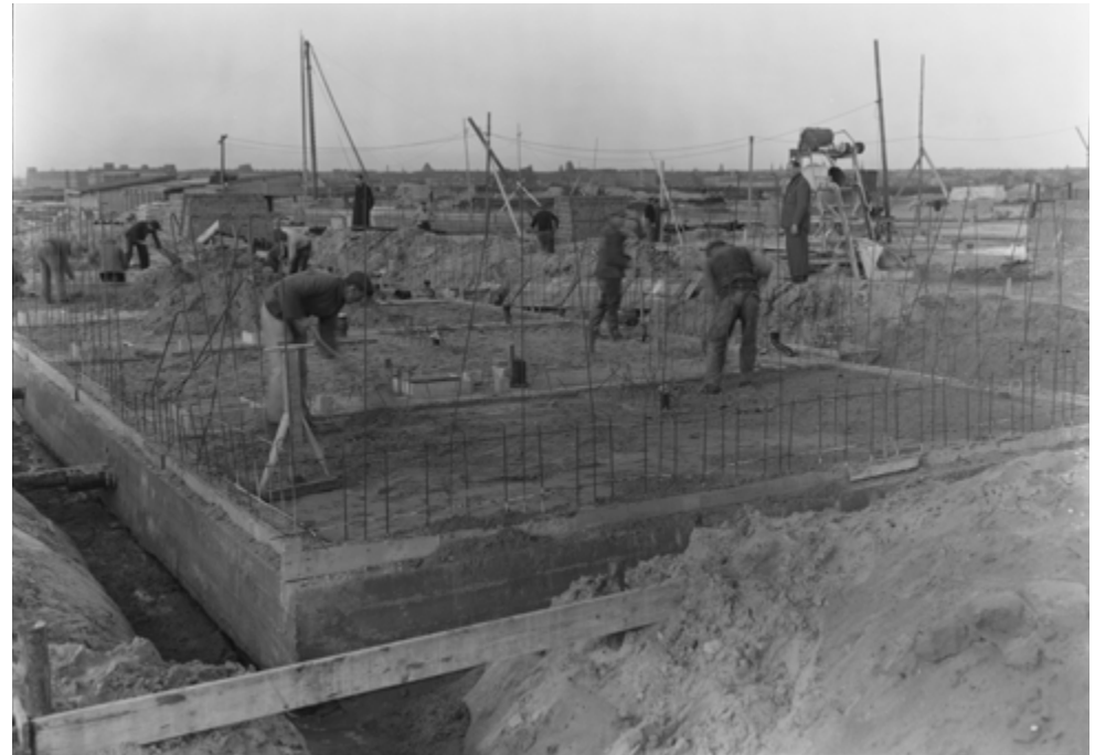
1946 oktober, fundering van gewapend beton.
